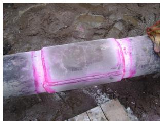
Reparación del defecto, según norma API
