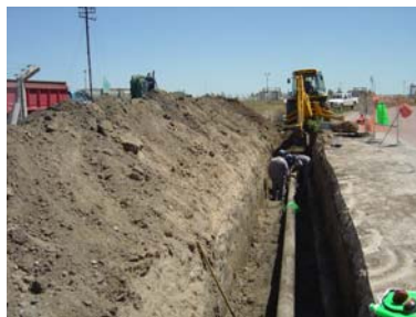
Tareas frentes N° 8 y N° 9: Cruce de oleopoliductos en camino acceso a Puerto Galván
