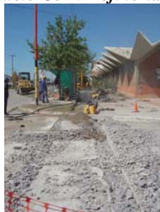
Tareas frente N° 1: Recoating oleoducto Cerri-Refinería
