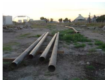
Desfile de caños para reemplazo oleoducto interconexión 8”.
