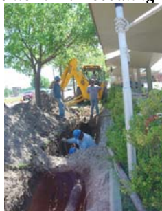
Tareas frente N° 1: Recoating oleoducto Cerri-Refinería
